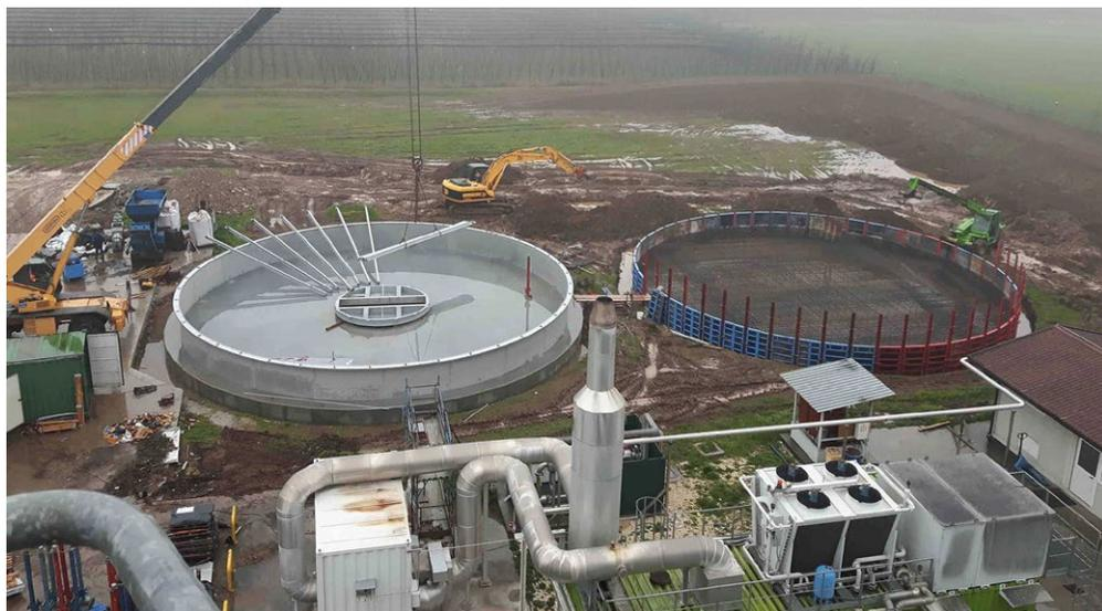
*L'impianto a biometano previsto a Canove di Govone da SNAM FERRERO prevede la costruzione di sette digestori di questo tipo, del diametro di 25 metri*
